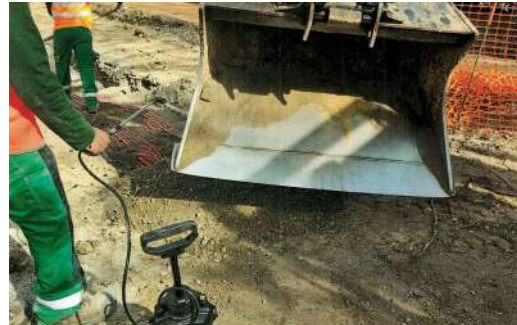
Désinfection post chantier (source Eurovia)
